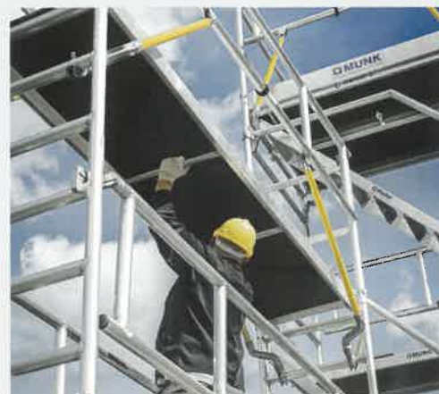
Bis zu 40 Prozent Gewichtsersparnis bietet die neue Ergo-Plattform der Munk Günzburger Steigtechnik im Vergleich zu herkömmlichen Plattformen. (Foto: Munk Group)
